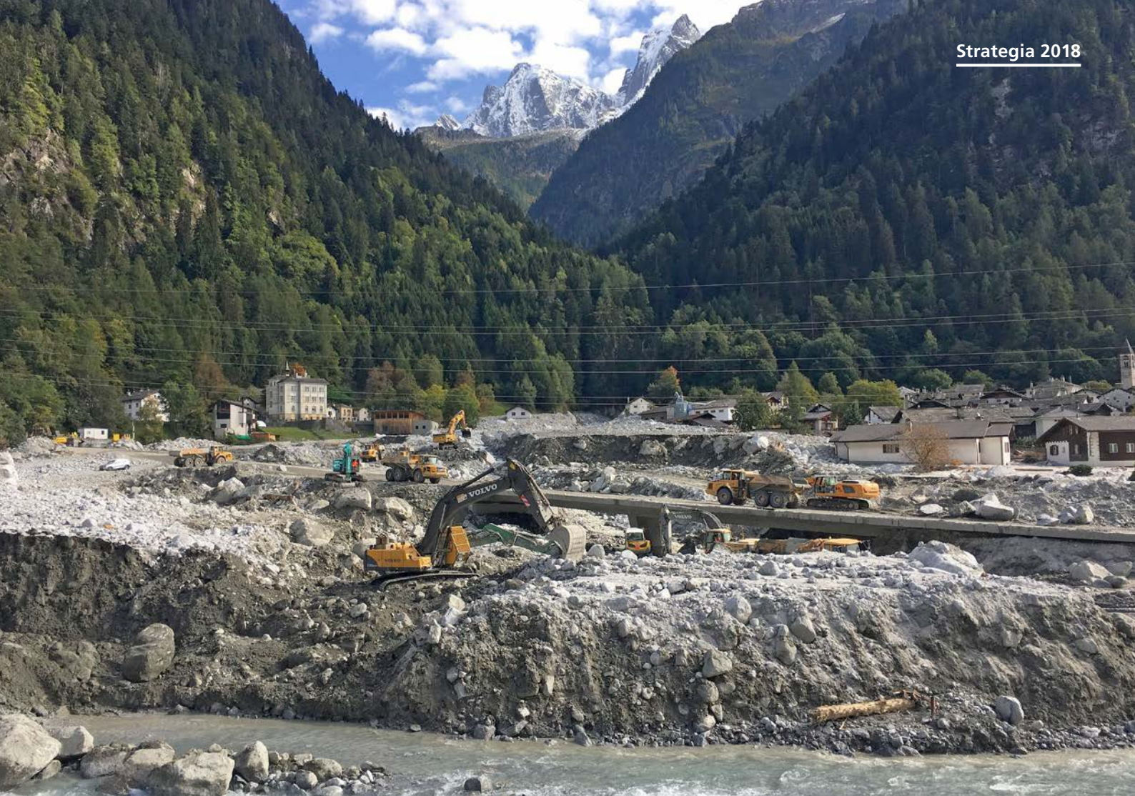
Lavori di sgombero nella grigionese Bondo dopo la frana del Pizzo Cengalo nell'agosto 2017.
