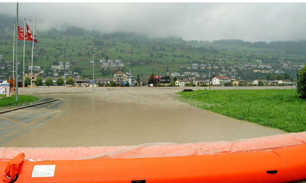
Gli elementi di diga Beaver hanno una funzione di bloccaggio in caso di piene e proteggono qui il Comune di Ennetbürgen (NW) contro le acque alte dell'Aa di Engelberg.
