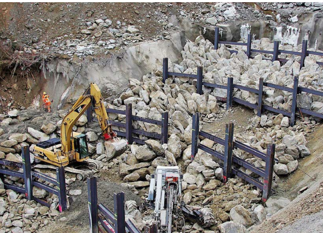
Costruzione di una barriera contro le colate detritiche nello Spreitgraben presso Guttannen nell'Haslital bernese. La costruzione metallica a mo' di staccionata lascia passare l'acqua e trattiene il materiale detritico.
