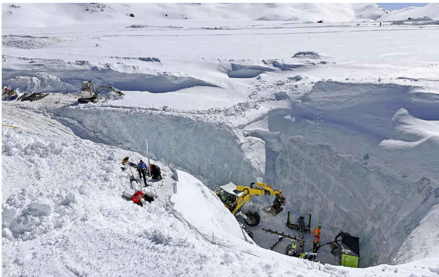
Sul ghiacciaio della Plaine-Morte nel 2019 è stato realizzato un canale nel ghiaccio che consente di mantenere basso il livello del lago glaciale, proteggendo così la Obersinnental sul lato bernese da grandi deflussi.
