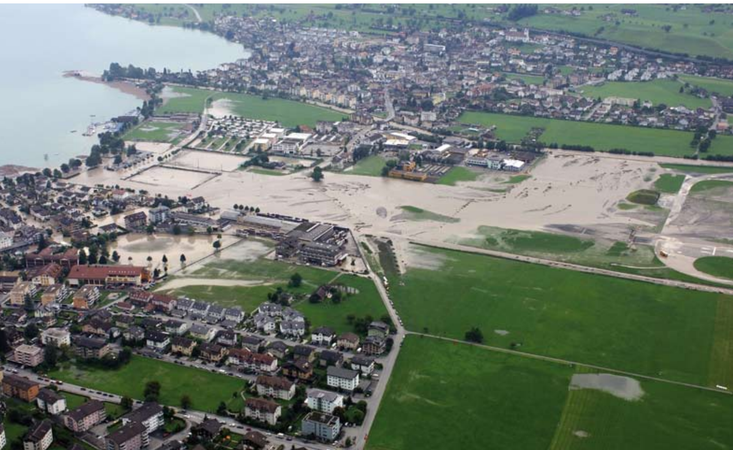
Piena del torrente Aa di Engelberg, nei pressi della foce tra Buochs ed Ennetbürgen (NW). In situazioni critiche, l'aerodromo funge da corridoio di deflusso.
