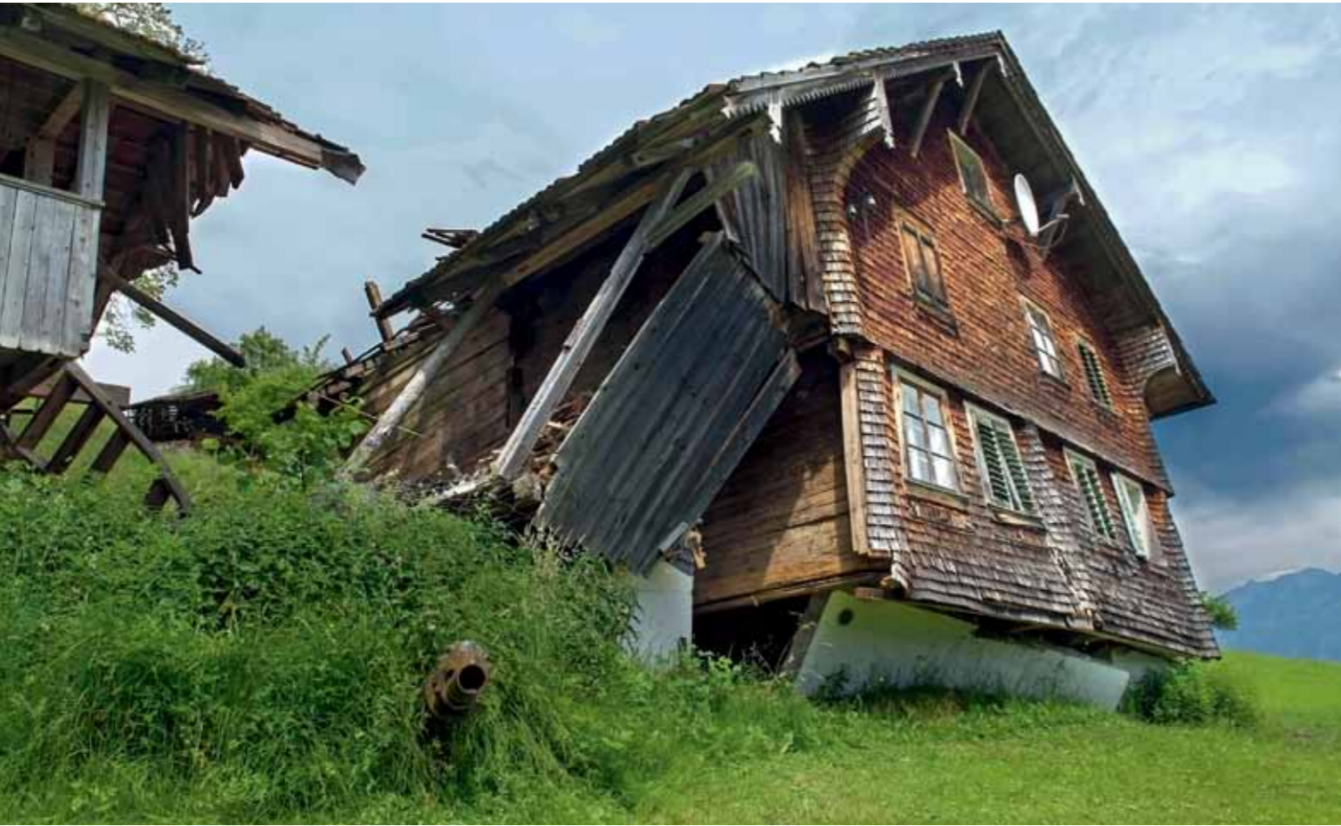
À l'avenir, il ne devrait plus être possible de construire dans les secteurs menacés par de vastes glissements de terrain, comme ici à Hintergraben, près de Sarnen (OW).
