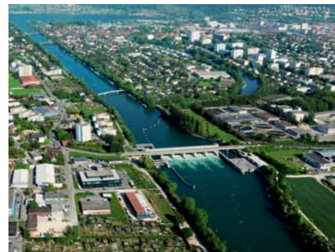
Le barrage de régulation de Port, près de Bienne, permet de gérer préventivement le niveau de l'Aar et des trois lacs du pied du Jura. L'appareillage placé sur un gradin escarpé du Bisgletscher, à l'aplomb de Randa (VS), déclenche l'alarme en cas d'avalanche ou de chute de glace.
