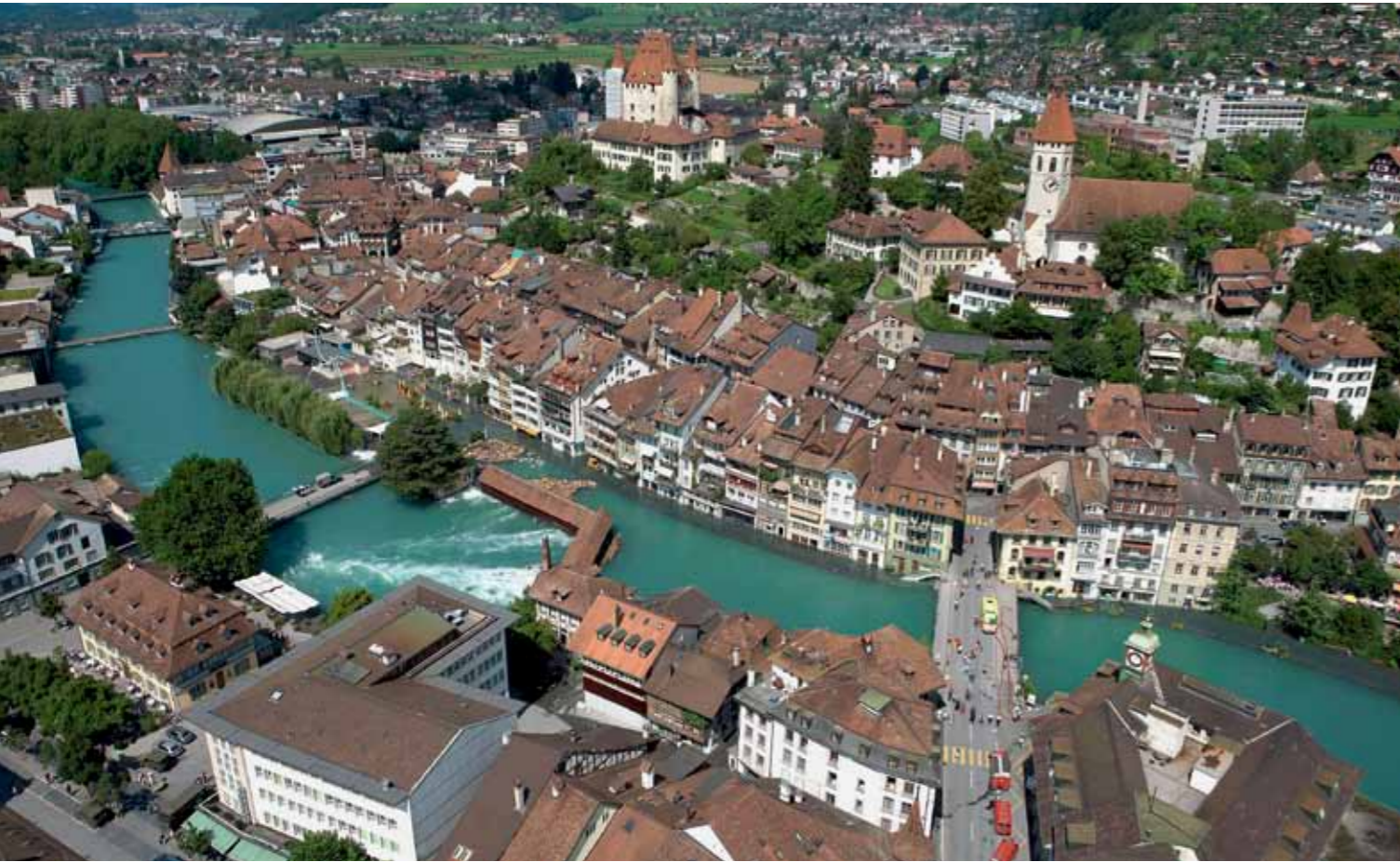
Grâce à l'aménagement d'une galerie de décharge, la ville de Thoun est désormais mieux protégée contre les inondations que lors des crues de 2005.
