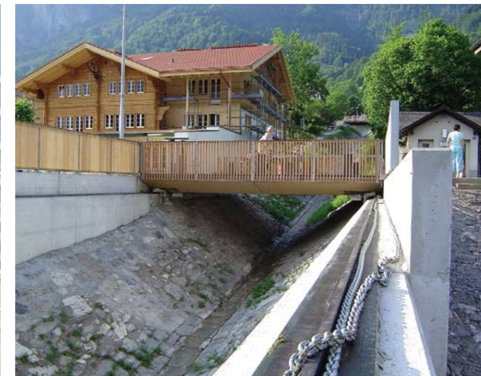
Bauliche Schutzmassnahmen als Teil des integralen Risikomanagements: Lawinerverbauungen ob Zermatt VS und verschiebbare Brücke über den Trachtbach in Brienz BE.
