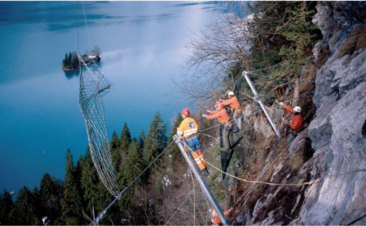
Montage eines Steinschlagnetzes zur Sicherung der Autobahn am Südufer des Brienzersees.
