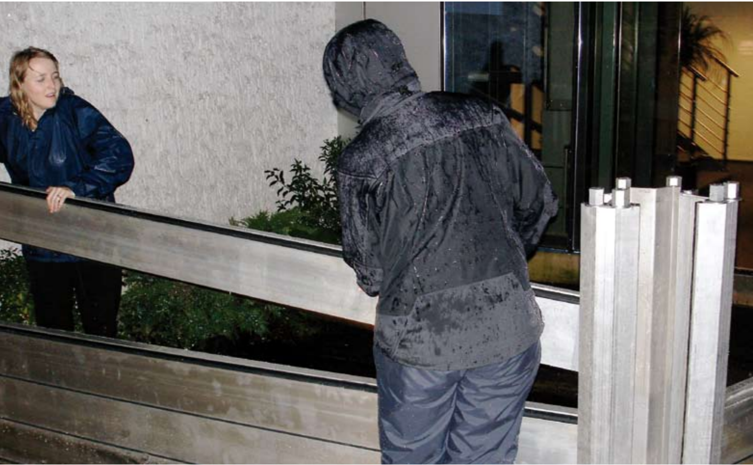
Temporärer Objektschutz zur Abwehr von Hochwasser im Berner Mattequartier.
