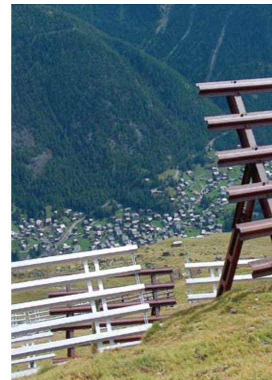
Bauliche Schutzmassnahmen als Teil des integralen Risikomanagements: Lawinerverbauungen ob Zermatt VS und verschiebbare Brücke über den Trachtbach in Brienz BE.
