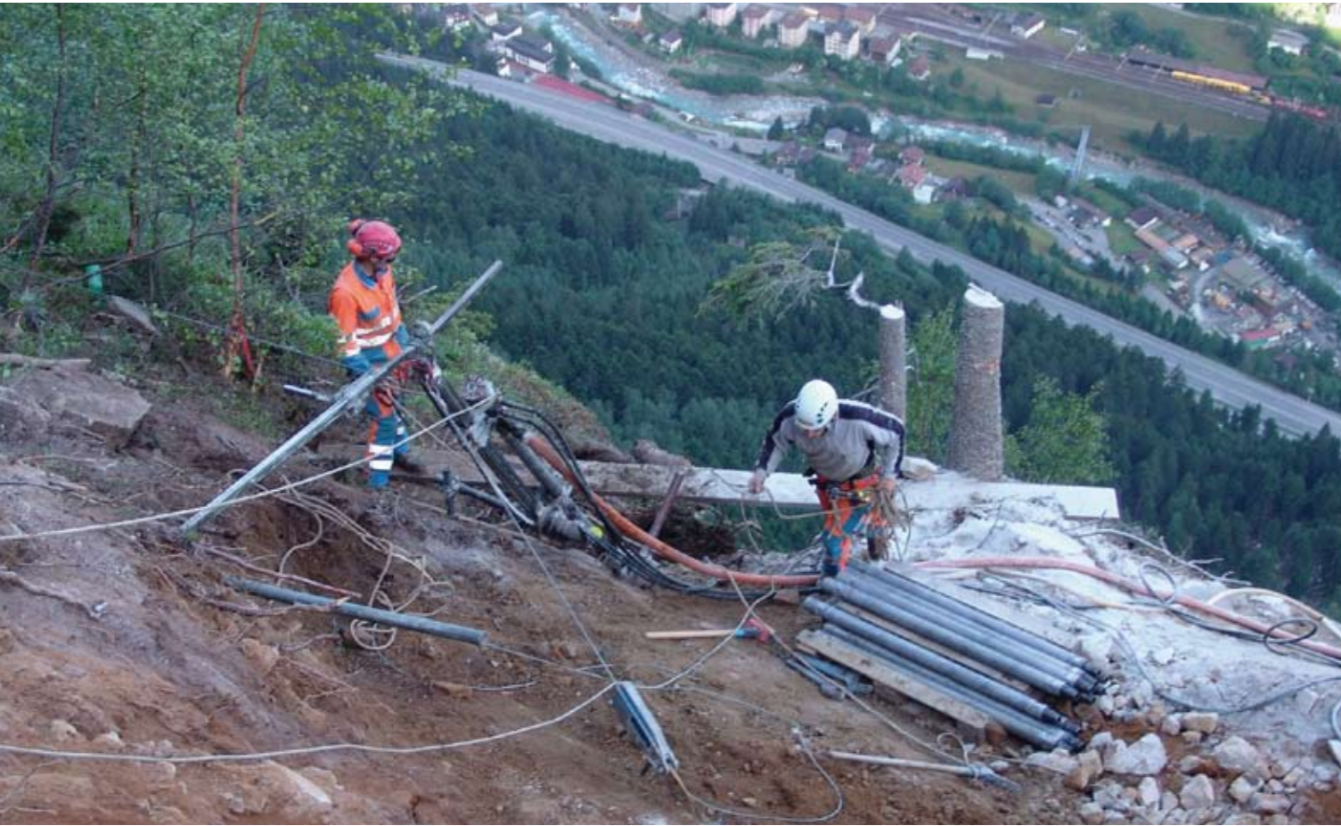
Sicherungsarbeiten ob Gurtellen UR zum Schutz der Gotthard-Autobahn vor Steinschlag.
