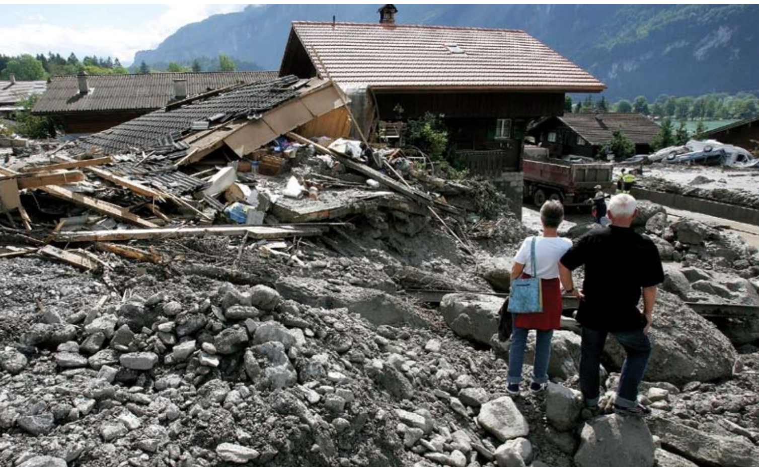
Zerstörter Dorfteil in Brienz BE nach einem Murgang des Glyssibachs im August 2005.
