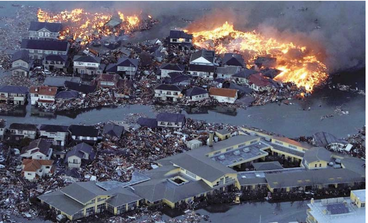
Effets catastrophiques du violent tremblement de terre subi par le Japon en mars 2011, qui a généré un tsunami et déclenché des incendies d'installations techniques dans la ville côtière de Natori.
