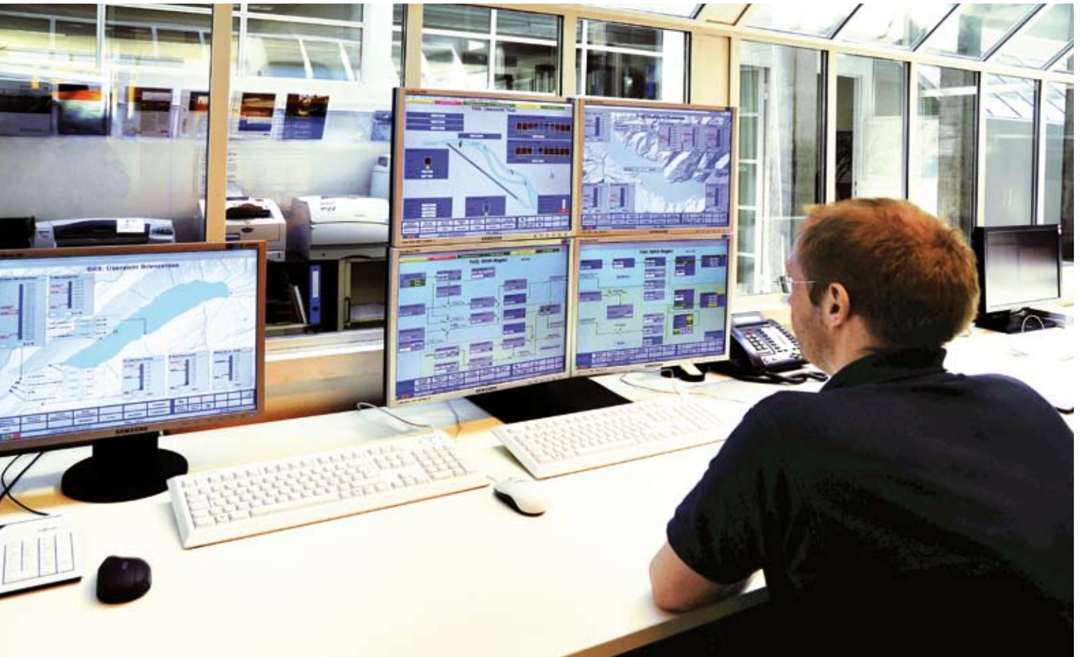
Le niveau des grands lacs peut être abaissé préventivement à la centrale de régulation du canton de Berne lorsqu'une crue est imminente.
