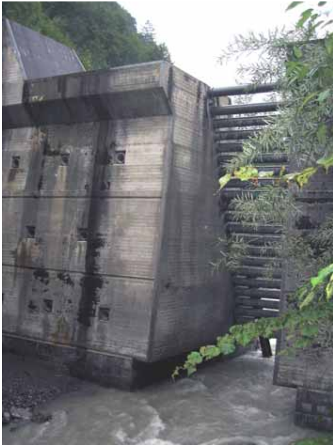
Abb. 4.5: Geschiebestausperre Stiglissammler im Schächen oberhalb von Bürglen UR. Geschieberückhaltevolumen ca. 100'000 m 3 (Aufnahme H. Duss, 2005).
