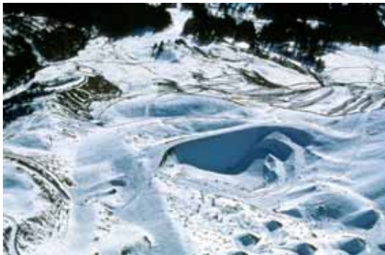
Abb. 7.1: Auffangdamm Dorfbach, im Vorfeld des Auffangraumes gibt es Bremshöcker, die wegen ihrer kleinen Höhe und konusförmigen Form nur eine kleine Wirkung zeigen dürften.
