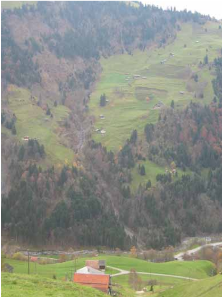
Abb. 5.3: Wilerlibach mit Einmündung in den Schächen. Aufnahme H. Duss November 2005 (nach den Unwettern). Das Wohnhaus und die zwei Ställe befinden sich in Bildmitte im Bereich der Verbauung, linksufrig und oberhalb der Rutschfläche. Im Einmündungsbereich gab es praktisch keine Geschiebeablagerungen durch die Unwetter.
