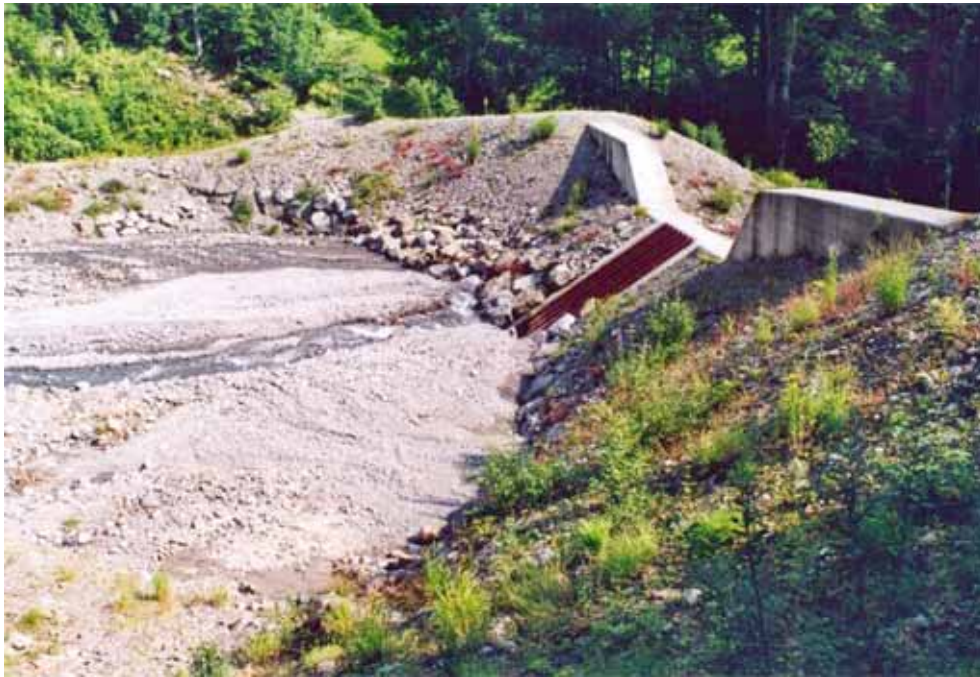
Abb. 4.7: Rechensperre (Schlitzsperre mit vertikalem schrägem Rechen) in der Guppenruns, Schwanden, GL.
