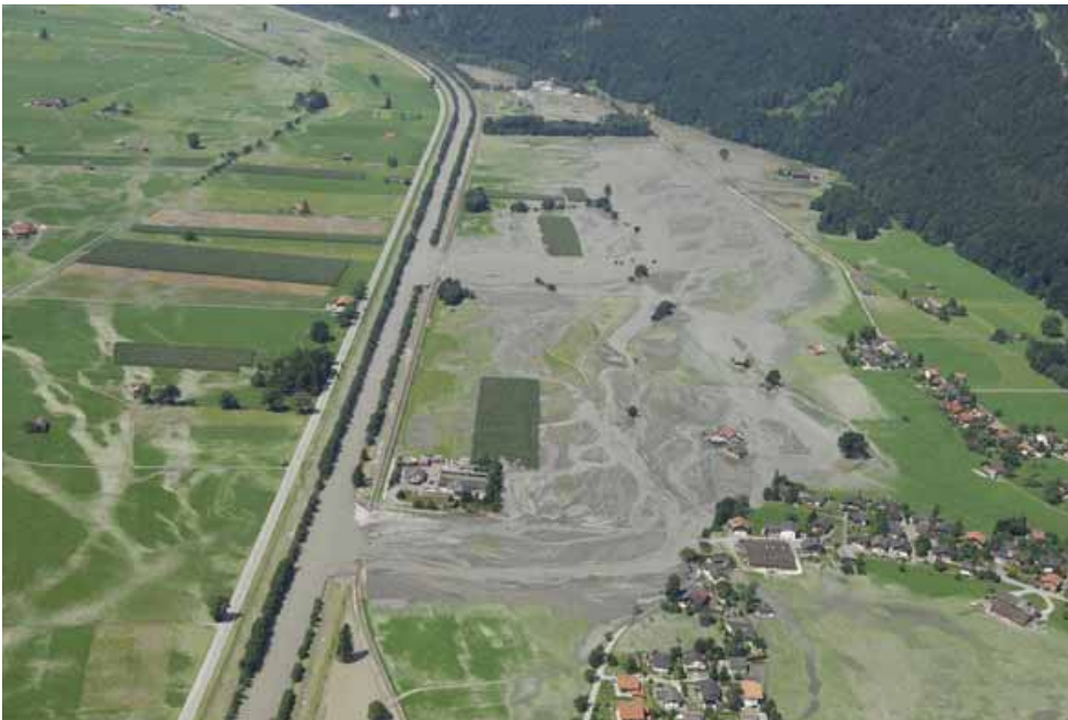
Abb. 5.2: Hochwasser 2005: Dammbüche an der Aare zwischen Meiringen und Brienz. Blick in Fliessrichtung.
