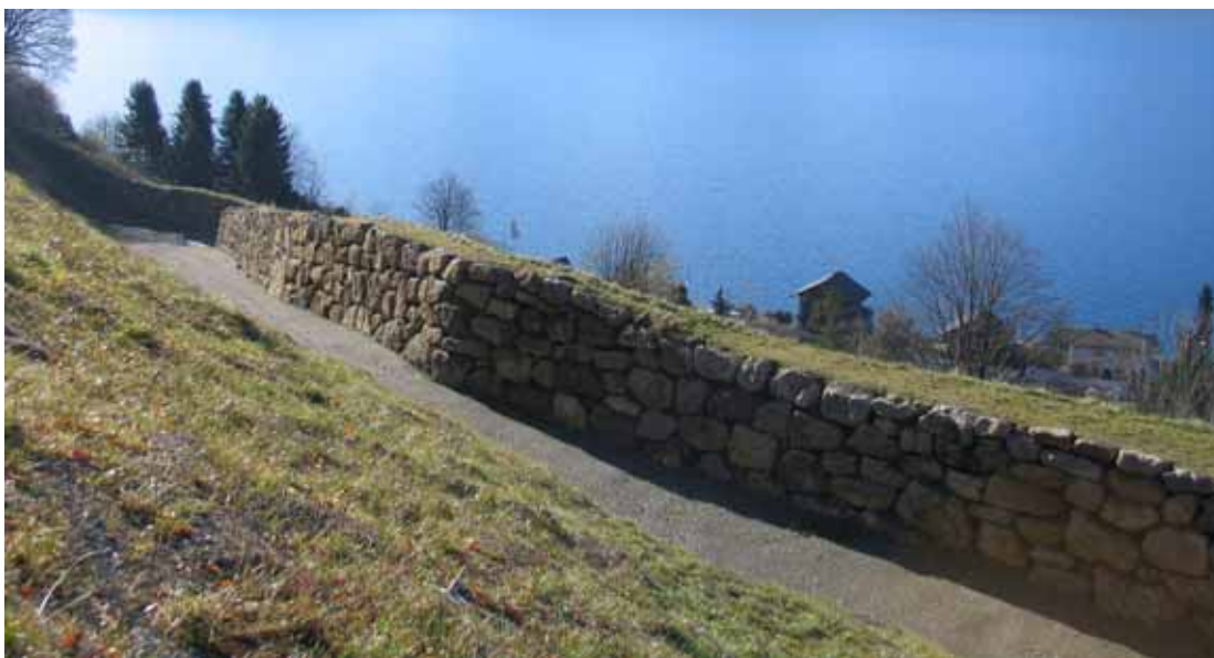
Abb. 8.1: Steinschlagschutzdamm Laugneri Weggis.
