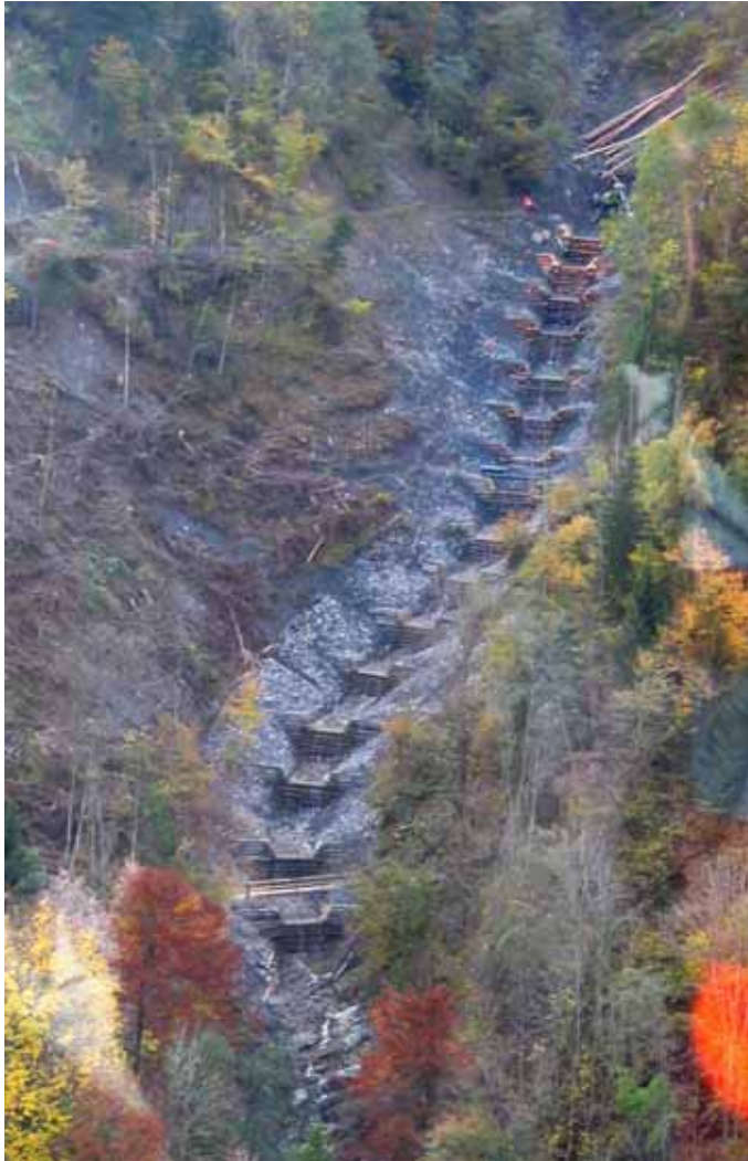
Abb. 5.1: Wilerlibach Heli-Aufnahme am 21.10.2005 nach Abschluss der Bauarbeiten (H. Duss).
