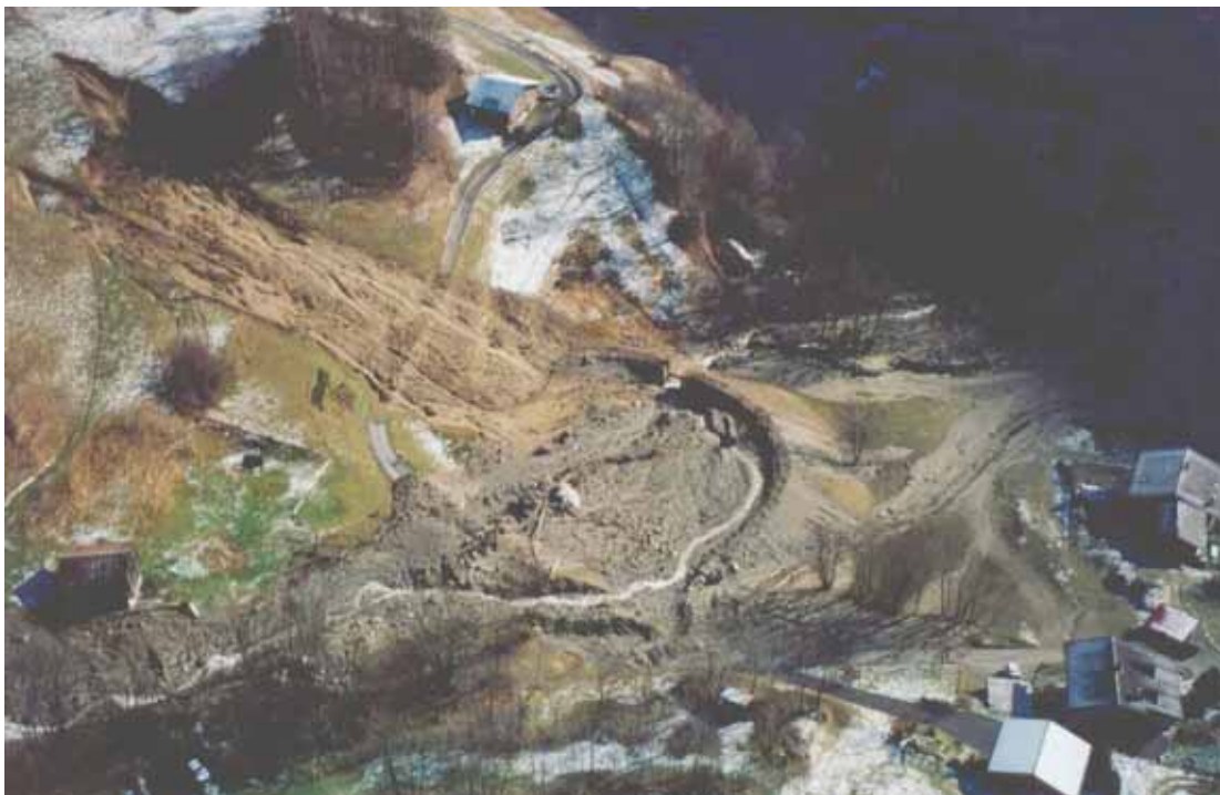
Abb. 4.3: Dieser Geschiebesammler wurde rechtsseitig überflossen. Auch beim Einlaufbauwerk trat bereits Material aus. Schliesslich versagen auch ein Teil des Auslaufrechens (Aufnahme C. Wilhelm, Amt für Wald GR).
