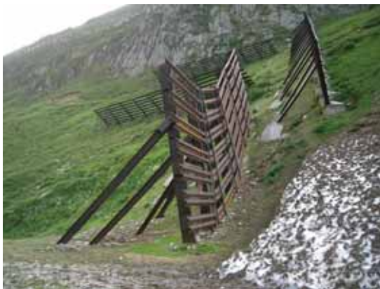
Abb. 4.9: Lawinenablenkwand aus Stahl auf dem Oberalppass. Nach einem grossen Lawinenniedergang mussten einzelne Stützen verstärkt werden.
