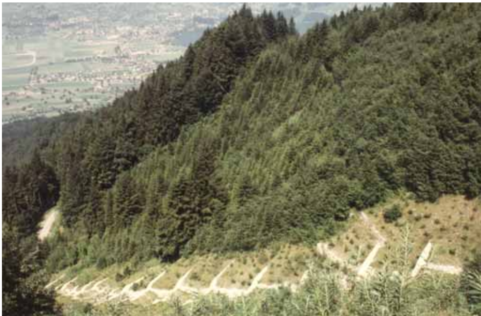
Abb. 3.5: Buochserrübi NW. Runsenkessel stabilisiert mit kombinierten technisch- biologischen Massnahmen. Im steilen Runsengerinne waren ursprünglich nur einzelne Sperren aus Blocksteinen vorhanden. Das Unwetter im August 1981 führte zu Sohlenabsenkungen zwischen den Sperren, Rutschungen in den seitlichen Hängen und erheblichen Schäden im Siedlungstraum von Buochs. 1983 wurde ein durchgehender Sperrenvollverbau (vorwiegend Stahlbetonsperren) angeordnet, der sich inzwischen sehr gut bewährt hat.
