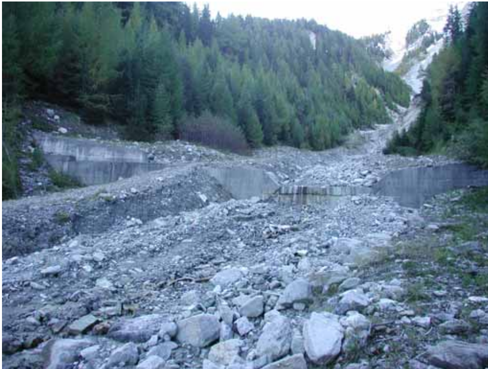
Abb. 3.14: Einschotterung der Sperren im Mittellauf (Aua da Mot, St. Maria, GR) (E. Frick, tur gmbh).
