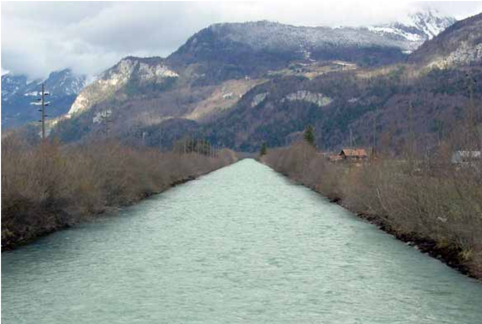
Abb. 5.1: Blick von der Brücke Balm flussabwärts.
