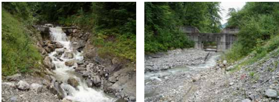
Abb. 6.5: Geschiebesammler Spissibach von 1998 (Aufnahmestandort im Geschiebesammler): links: Einlaufbauwerk, rechts: Abschlussbauwerk.
