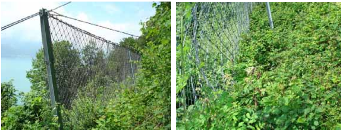
Abb. 7.3: Schutznetz mit 4 m Höhe und Krautschicht in der unteren Hälfte.
